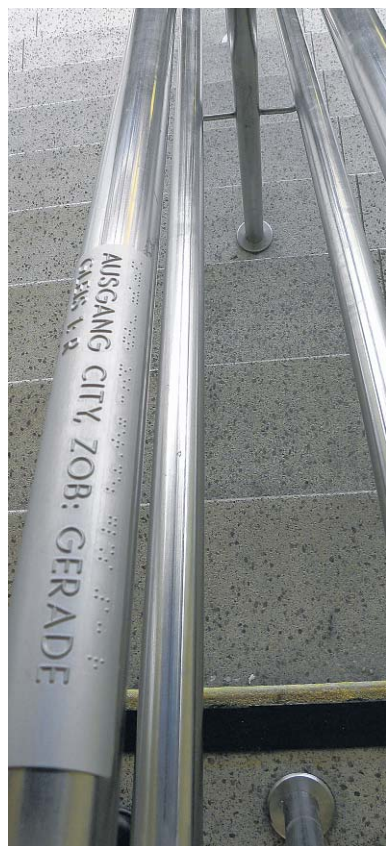
Keil- und Punktschrift am Treppengeländer auf dem Bahnhof erleichtern Sehbehinderten die Orientierung.
